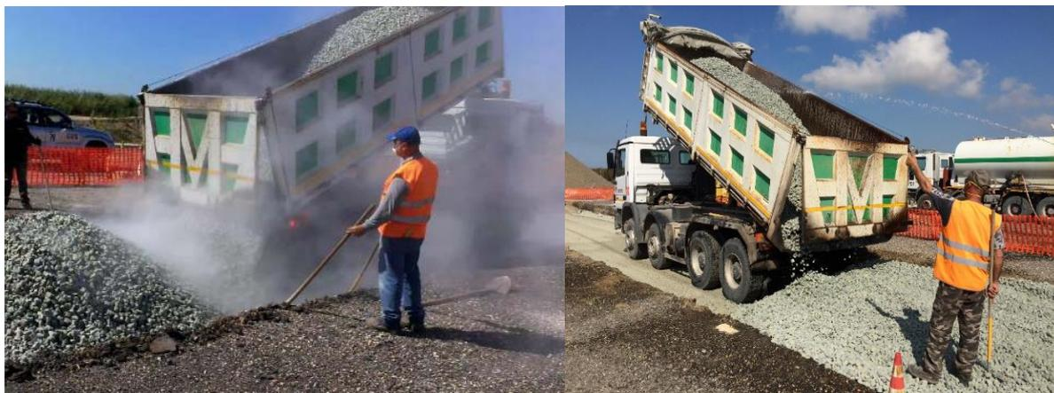
*Figura 6.2-2 Esempio di riduzione polveri dopo bagnatura durante lo scarico (senza bagnatura sx e con dx)*
