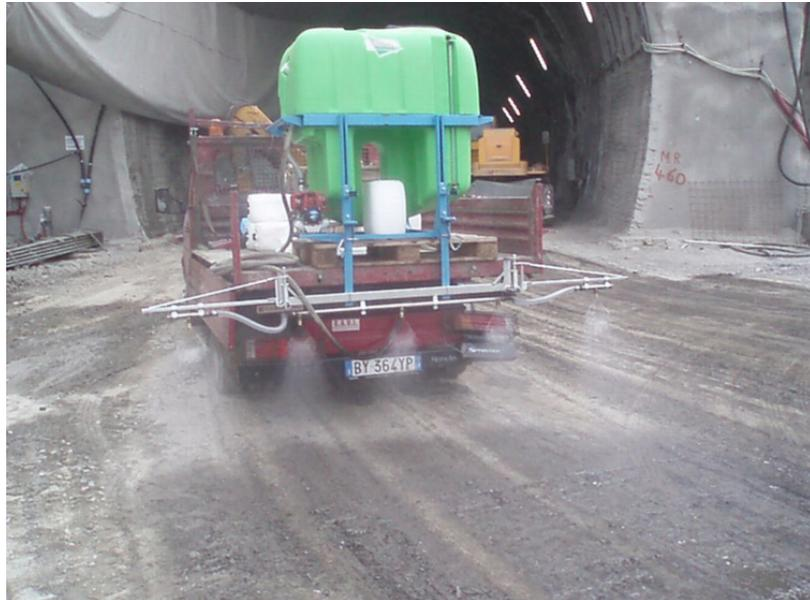
*Figura 6.2-4 Sistema di abbattimento tramite bagnatura piste non asfaltate*
